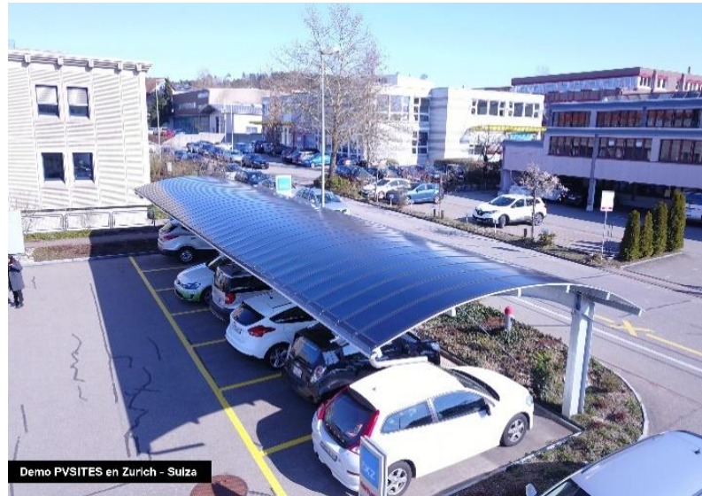
Figura 16. Ejemplo de Integración fotovoltaica en marquesina de aparcamiento de coches en Zurich (Suiza). Fuente: Proyecto PVSITES
