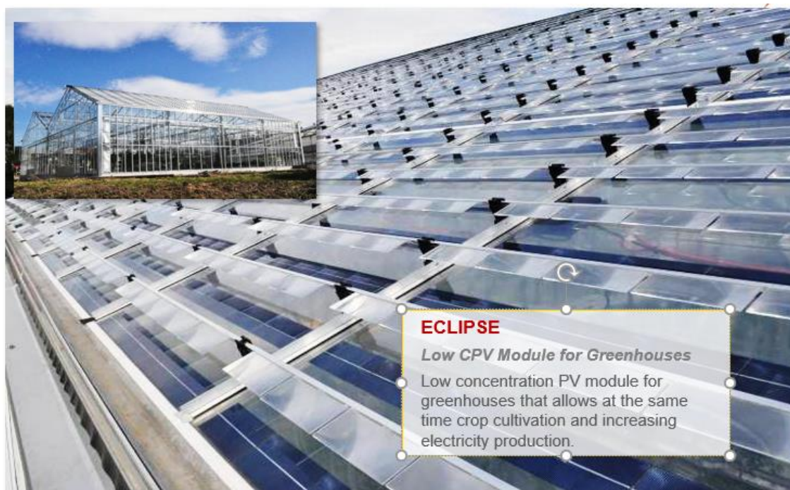
Figura 17. Ejemplo de Integración fotovoltaica de concentración en un invernadero con tecnología Eclipse en Derio (Vizcaya) Fuente: Tecnalia
