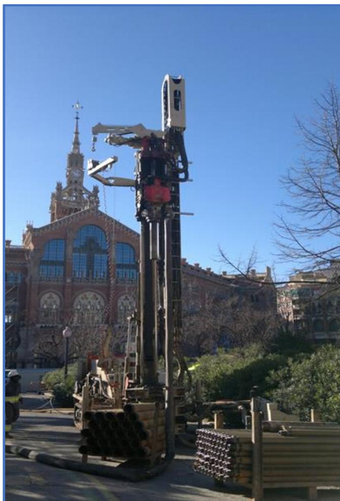
*Sistemas Geotérmicos para Climatización*
