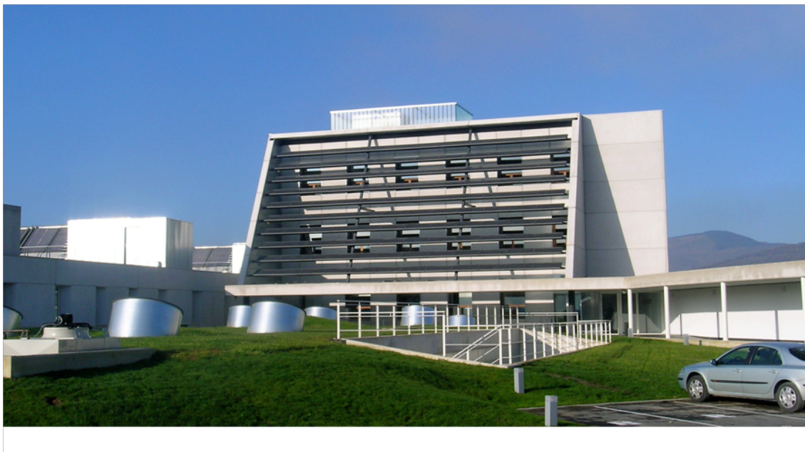
Figura 5. Instalación fotovoltaica la sede del CENER en Sarriguren. Cortesía de CENER.
