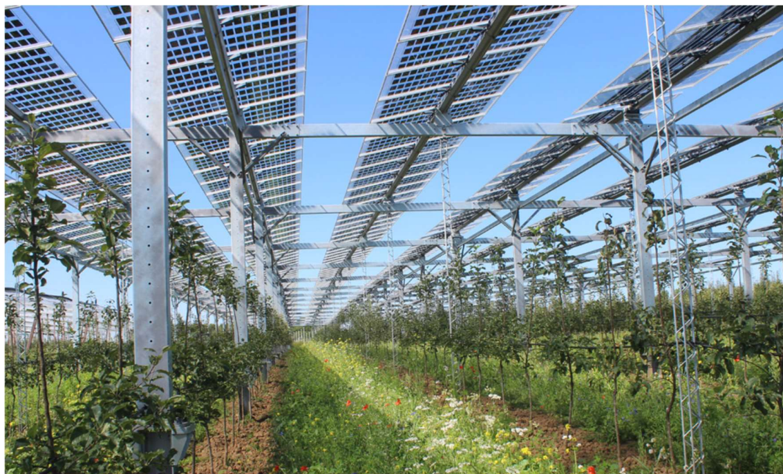
Ilustración 17 Proyecto de investigación para evaluar las sinergias entre el cultivo de la manzana y la agrovoltáica en Renania-Palatinado, Alemania. © Fraunhofer ISE
