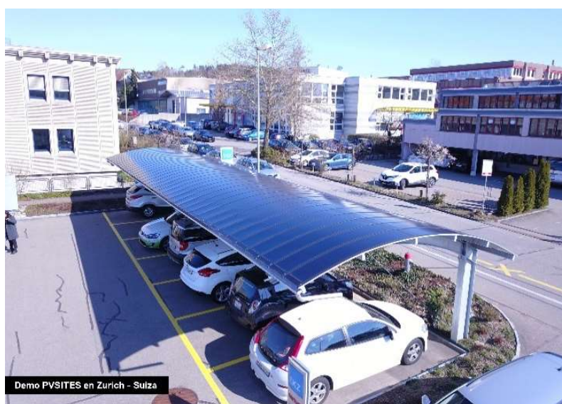
Ilustración 16: Ejemplo de Integración fotovoltaica en marquesina de aparcamiento de coches en Zurich (Suiza). Fuente: Proyecto PVSITES
